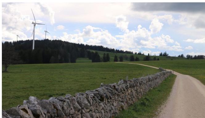
Parc éolien de Mont-Soleil et Mont-Crosin © Lagadec-Kempf.eu
