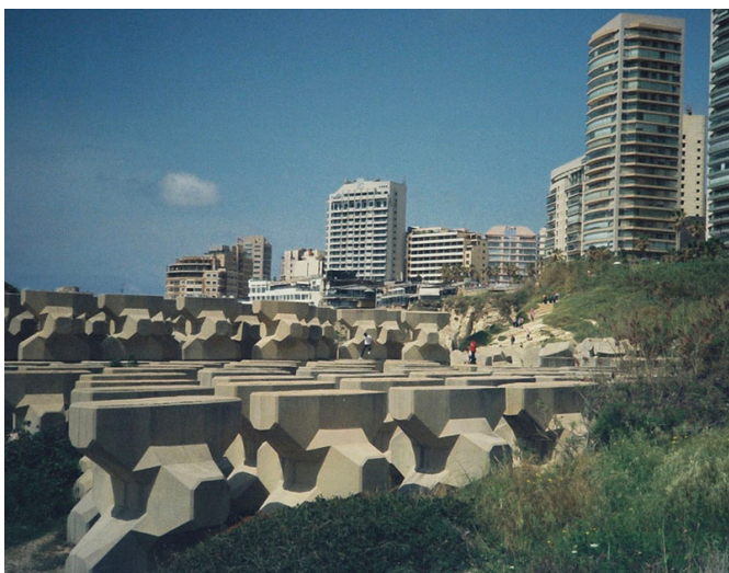
Les podes d'endiguement forment des motifs extraterrestres surplombés par des immeubles de marques qui dominent la côte. Des adolescents s'aventurent sur ces golems. ©Matéo Bouchaud
