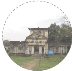
Nhà thờ Long Hưng Long Hung Church Diện tích: 1049 m 2 Area: 1049 m 2
