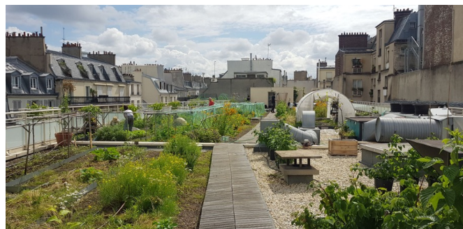
Toit du Bout du Monde. Centre Jean Dame, Paris 2e, géré par Toits Vivants. © Sébastien Goelzer
