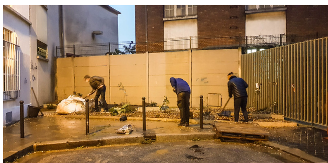
Impasse Molin, Paris 18e, plantations suite à une opération de débitumage ©Sébastien Goelzer
