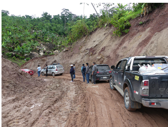
Sur la route menant au projet, la déforestation entraîne des éboulements fréquents © Coquin Bertrand
