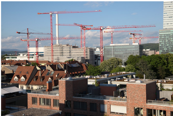
Voir et être vu : les vues et belvédères sont convoités pour leurs qualités, au risque de leurs fermetures progressives et de leur privatisation par quelques-uns. © Cédric Ansart
