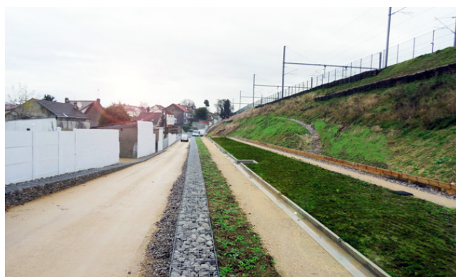
Talus ferroviaire du RER D, Goussainville, avant, pendant et après les travaux (avant plantation) © LAK+ Paysage
