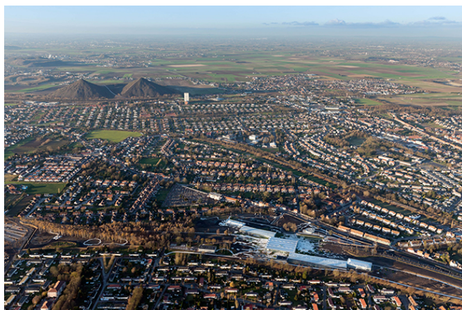
Vue aérienne, photo prise lors de l'inauguration du 04/12/2012 ©Ywan Baan
