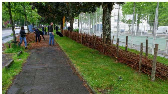
Fig. 2 : Constituer une haie de fascines avec les habitants pour délimiter l'espace public dans un langage bocager. Les arbres présents dans le tissu urbain depuis une quarantaine d'années participent à la constitution de ce nouvel espace public, Nantes Nord, mai 2017 © Simon Lacourt
